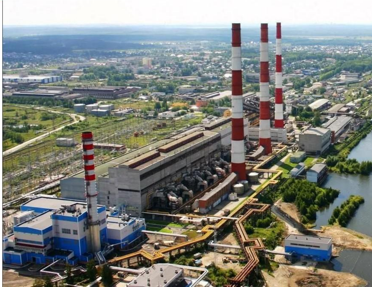
Среднеуральская ГРЭС (1580 МВт + 1327 Гкал)
