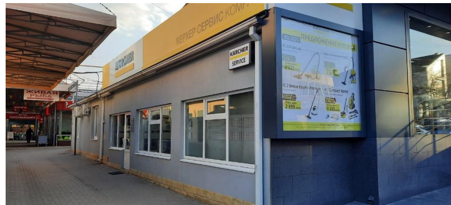
Сервисный Центр фил. г. Комрат / Реконструкция
