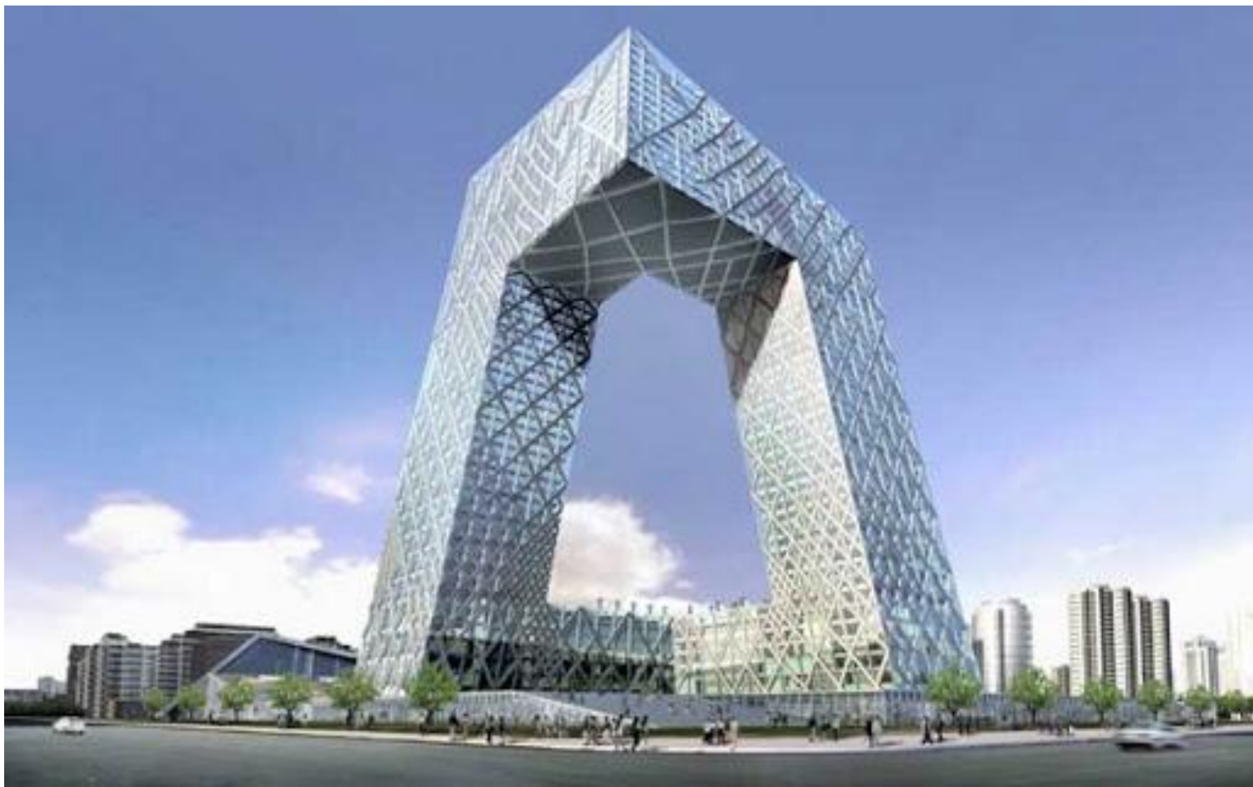
Здание центрального телевидения в Китае
