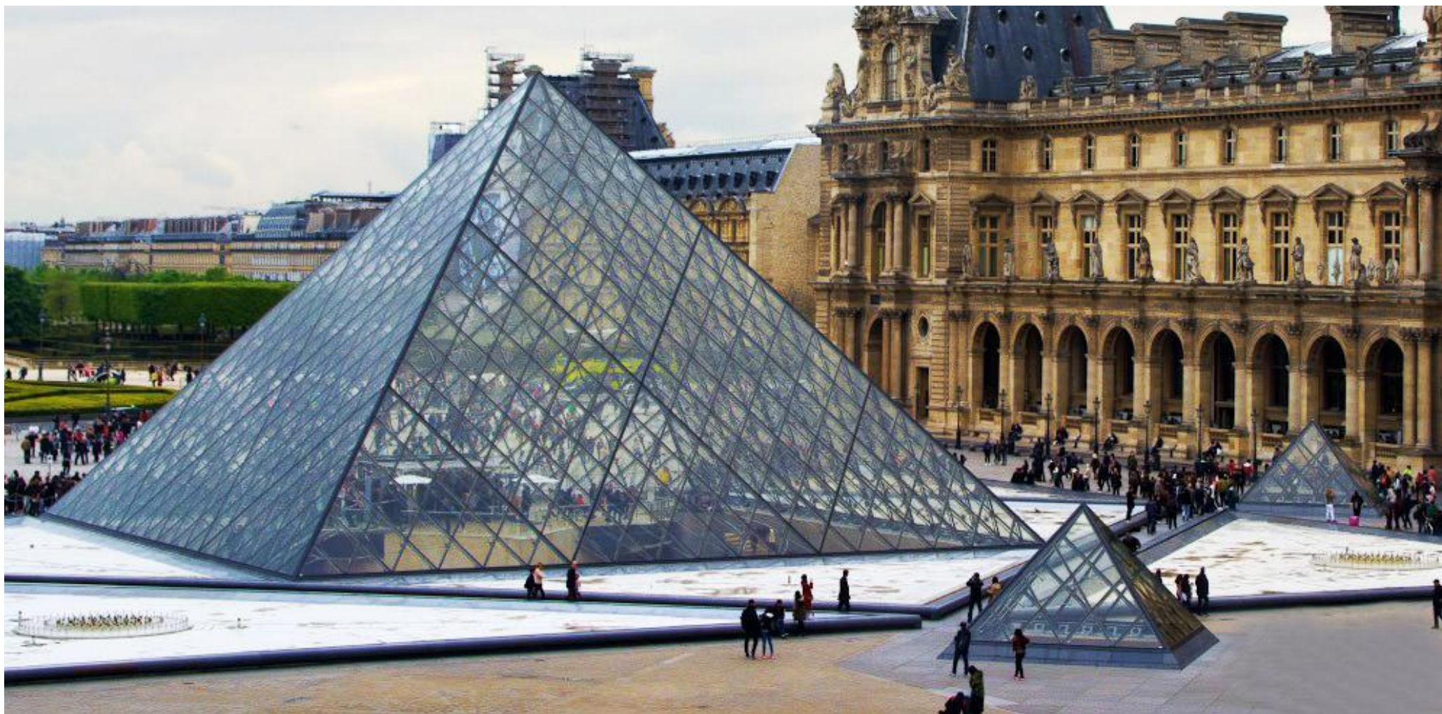
Вход в Лувр
