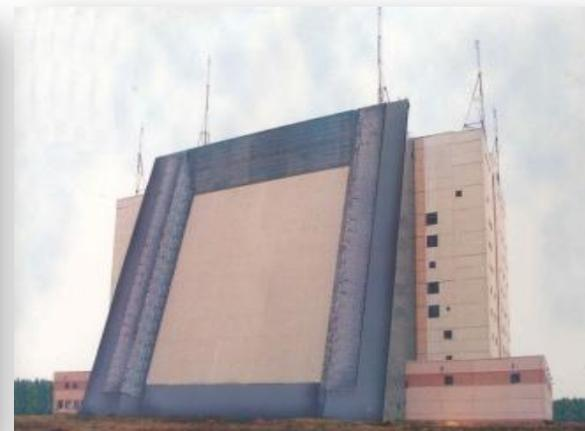
**Результатом этого явилось создание отечественных РЛС НГО с уникальными характеристиками и высокой стоимостью, требовавших применения развитого инженерного комплекса с водяным охлаждением аппаратуры, на который приходилось более половины стоимости изделия.**
