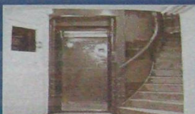
Лифт на одной из закрытых станций
