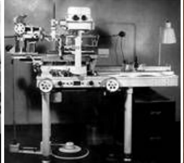
**Стереограф СД** – универсальный прибор механического типа второго класса точности, предназначенный для обработки плановых снимков формата 18 x18 см с преобразованными связками проектирующих лучей. Стереограф выпускается с 1956 г.
