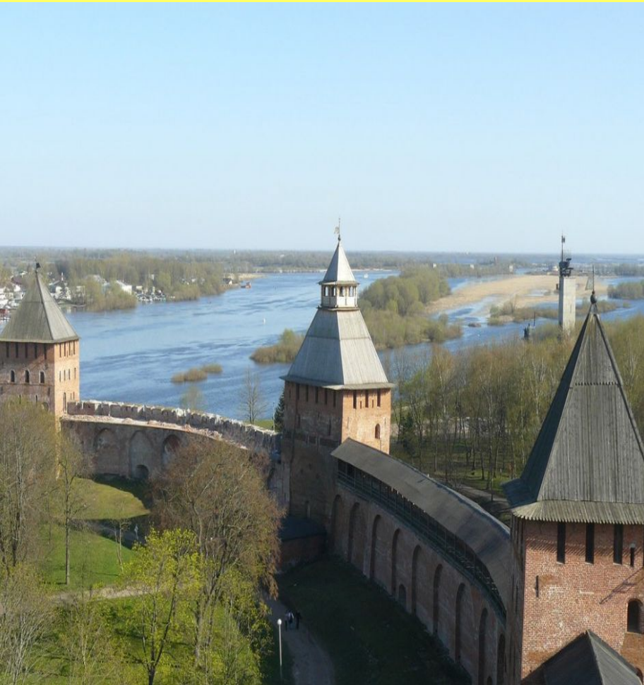
Стены и башни Новгородского Кремля. Современный вид.
