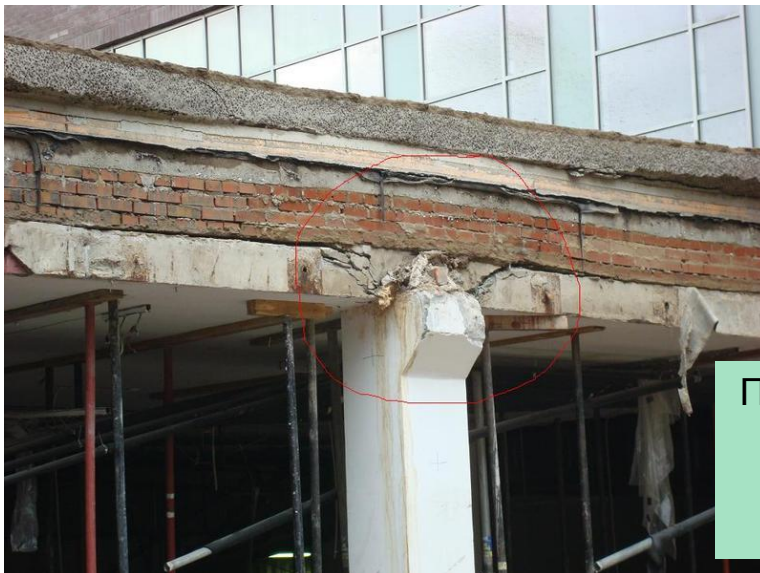
Строящееся монолитное здание. Владивосток, 2013 г.
