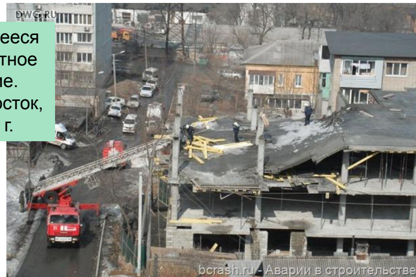
Подземный паркинг. Москва, 2009 г.
