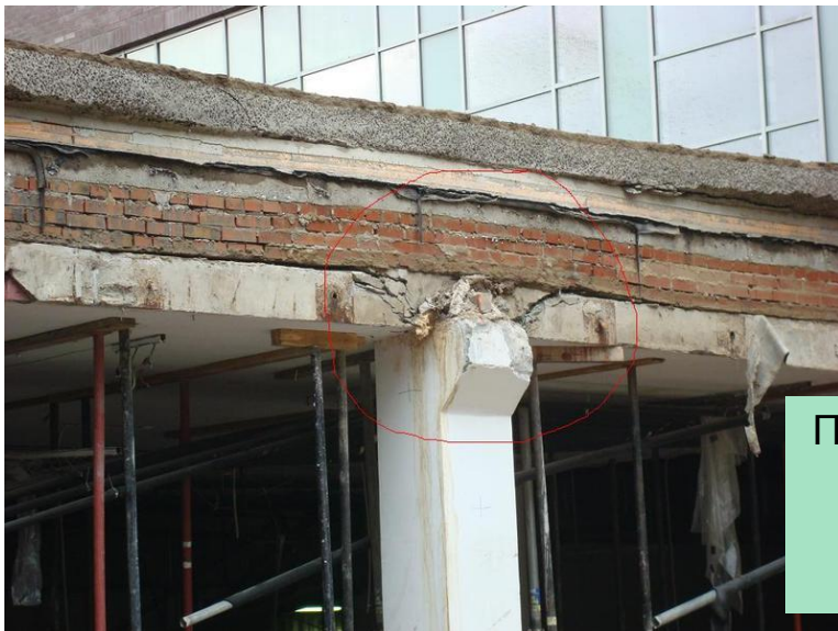
Строящееся монолитное здание. Владивосток, 2013 г.
