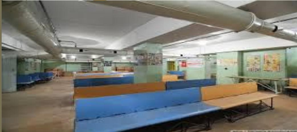
Система воздухообмена, как правило, работает в двух режимах: чистой вентиляции (очистка воздуха от пыли) и фильтро-вентиляции. В убежищах высшей категории и расположенных в пожароопасных районах может дополнительно предусматриваться режим полной автономности с регенерацией воздуха внутри убежища.
