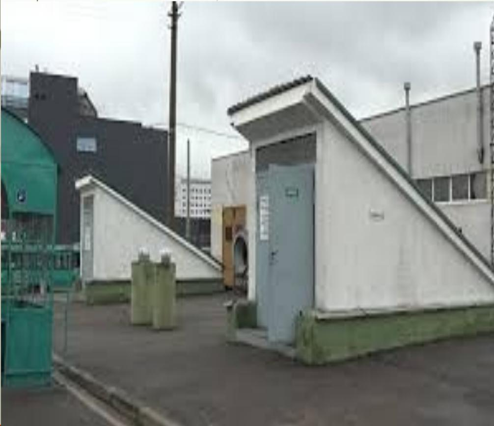
**В убежище устраиваются, как правило, не менее двух входов (выходов); в убежищах малой вместимости - вход (выход) и аварийный выход. Во встроенных убежищах входы могут делаться с лестничных клеток или непосредственно с улицы. Аварийный выход оборудуется в виде подземной галереи, оканчивающейся шахтой с оголовком или люком на незаваливаемой территории.**
