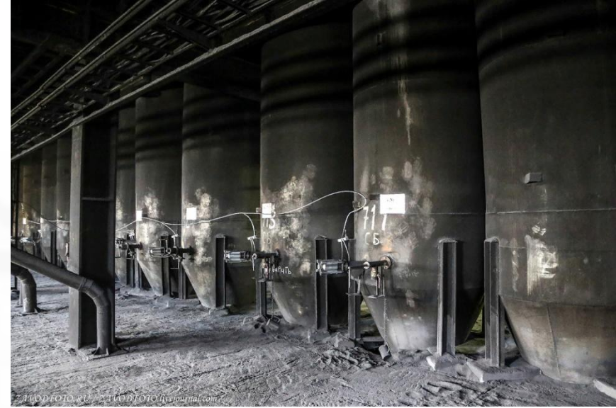
Бункера углеподготовительного цеха
