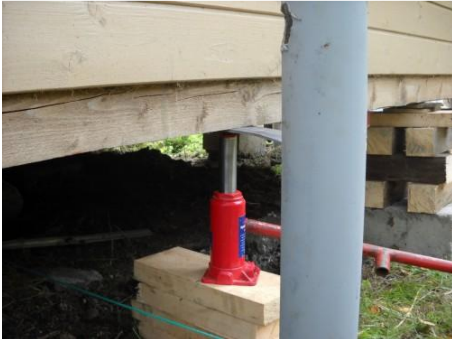
Поднятый домкратом сруб деревянного дома
