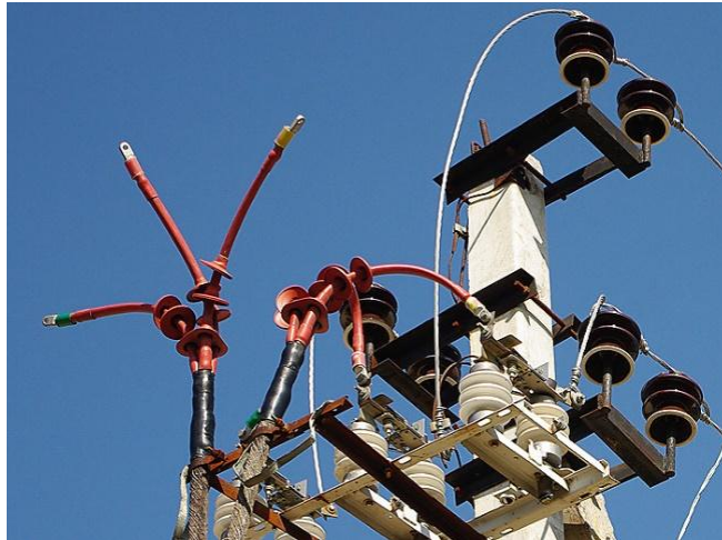
подключение к воздушным линиям
