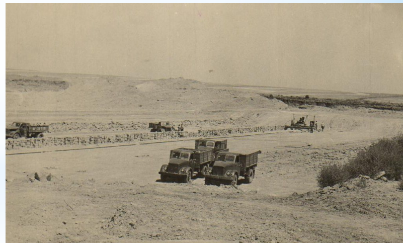
Строительство асфальтированной трассы п. Орловский – х. Курганный.
