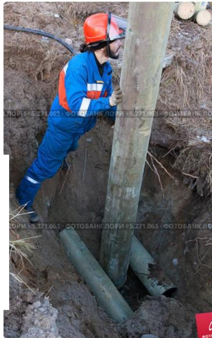
Установка деревянной опоры ЛЭП с ригелем в котлован
