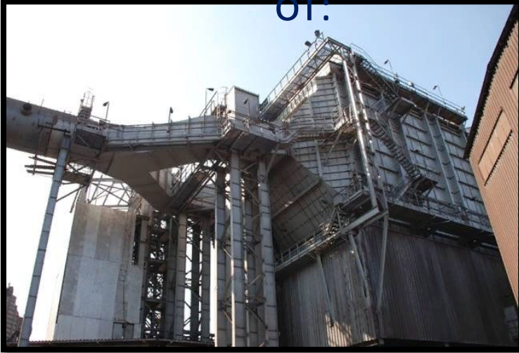
А) подбункерных помещений
