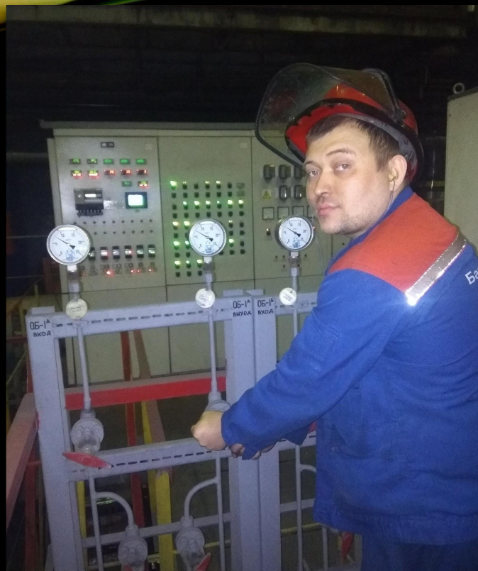
Проверка работоспособности и технологических манометров
