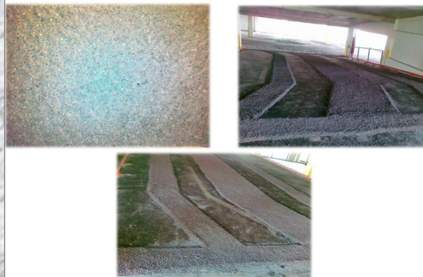
Абразивные покрытия на основе реакционно-порошкового бетона
