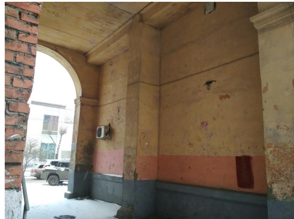
Общий вид стороны
