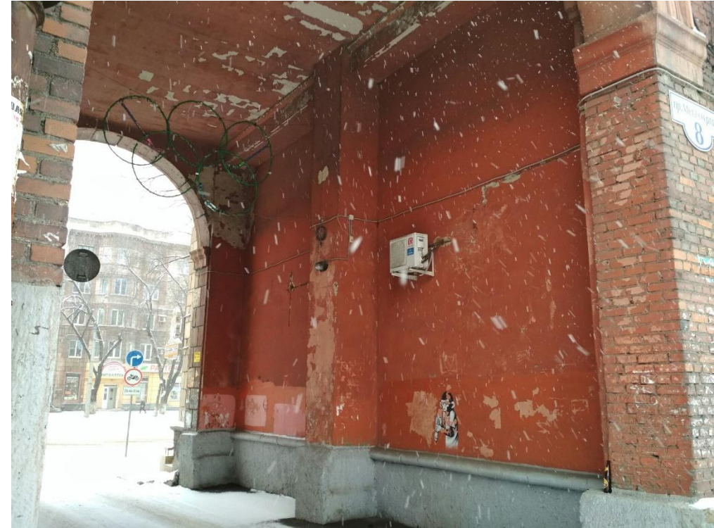
Общий вид стороны
