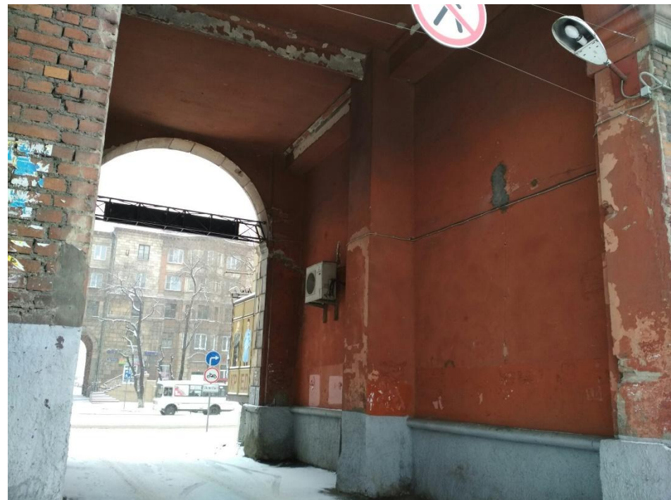
Общий вид стороны
