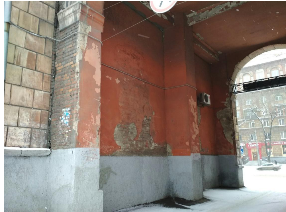
Общий вид стороны
