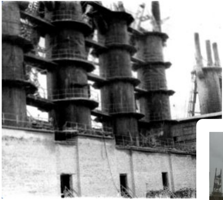
1949 год, строительство 5-ти шахтных печей, работающих на каменном угле
