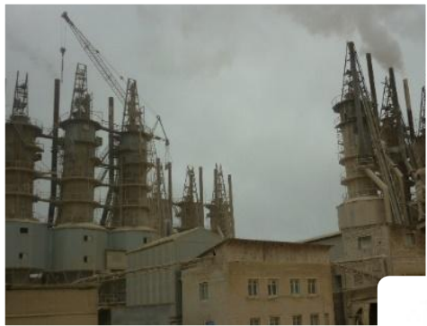
1971 год, печи были переведены с угля на газ, обжиг извести ведется на природном газе
