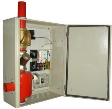
**Эксгаустер** – устройство, обеспечивающее при срабатывании спринклерного оросителя активный сброс давления воздуха из питающего трубопровода .
