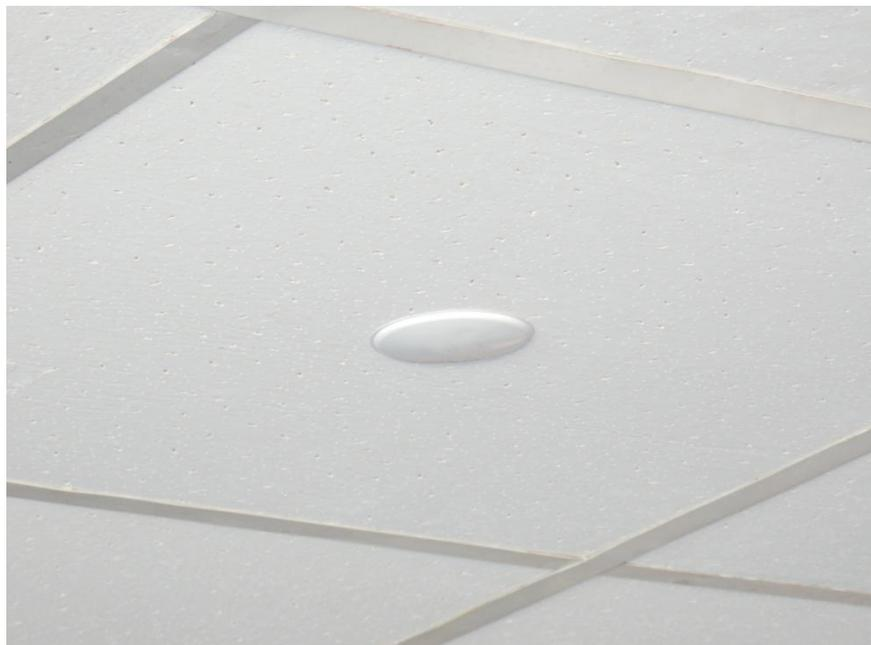
Оросители «СВК-10», «СВК-12», «СВК-К80», «СВК-К115», «SSP-К80» «SSP-К115» устанавливается в автоматических установках водяного пожаротушения, для равномерного распределения по защищаемой площади огнетушащего вещества и устанавливается в подвесных потолках в помещениях с высокими требованиями к внешнему виду. Климатическое исполнение В, категория размещения 3 с нижним температурным пределом в водозаполненной системе (+5°С), в воздушной (-60°С).
