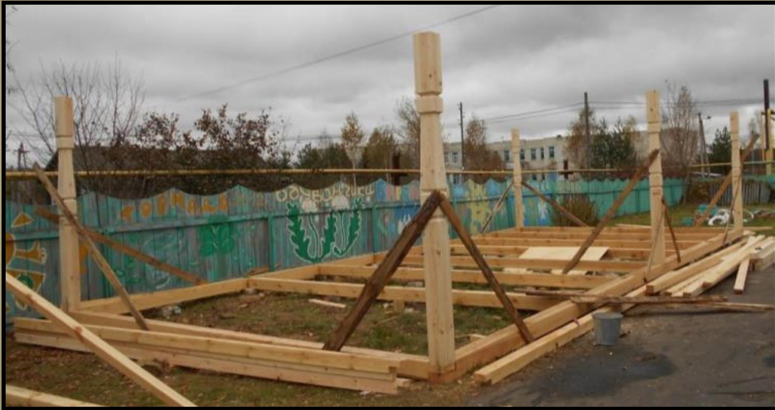
Стойки устанавливаем на основании вертикально по уровню, закрепляем распусками.
