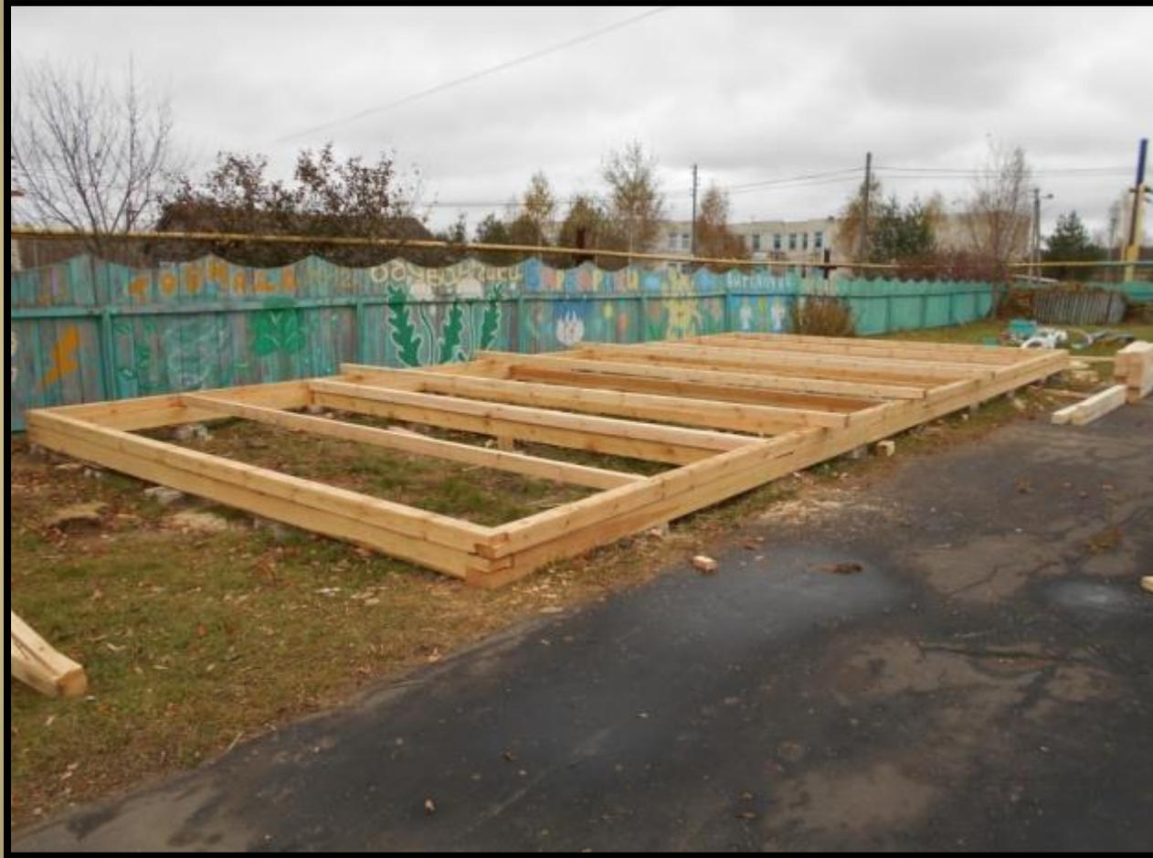
Строительство начинаем с фундамента. По периметру заливаем столбы через каждые 1,5 метра, выравниваем по уровню. Из брусьев 150 на 150 строим каркас нижнего основания
