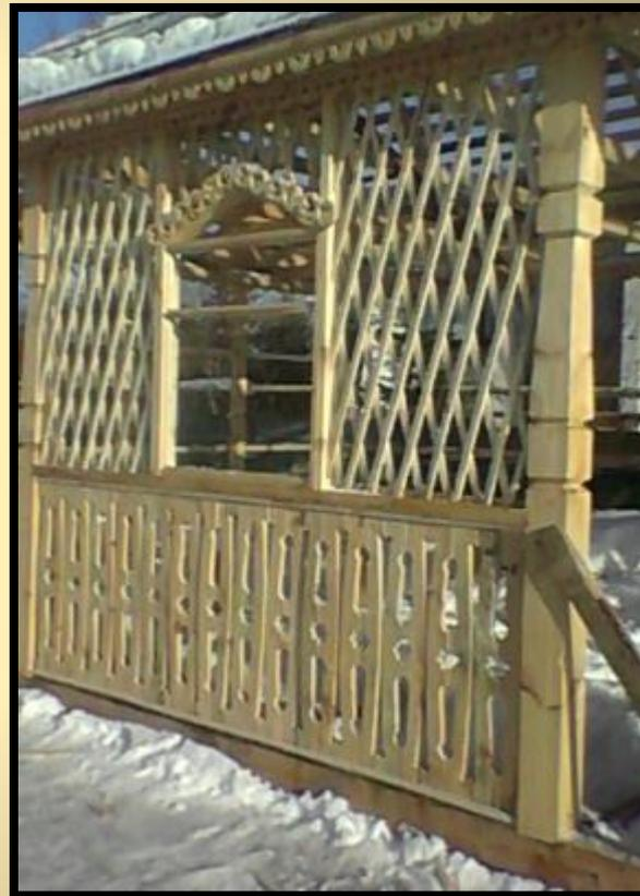
Межоконные проемы забиваем рейкой в 2 направлениях.
