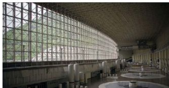
Контроль геометрии оборудования ГЭС
