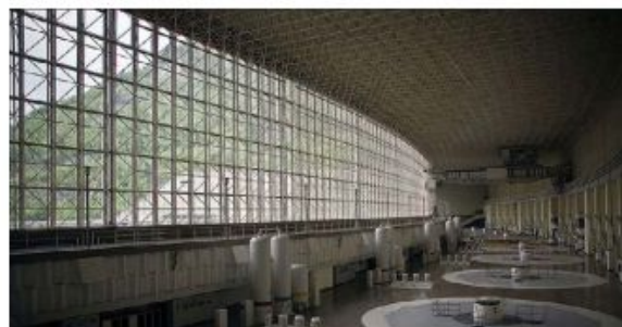
Контроль геометрии оборудования ГЭС
