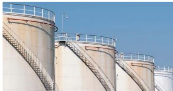
Осмотр и обмер нефтяных резервуаров
