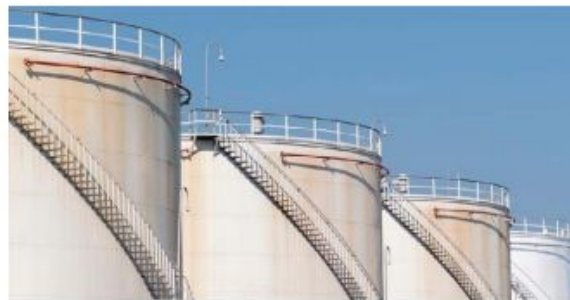
Осмотр и обмер нефтяных резервуаров
