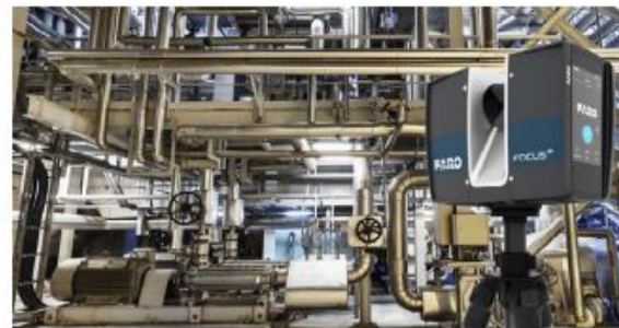
3D-сканирование помещения с целью оптимального размещения нового оборудования
