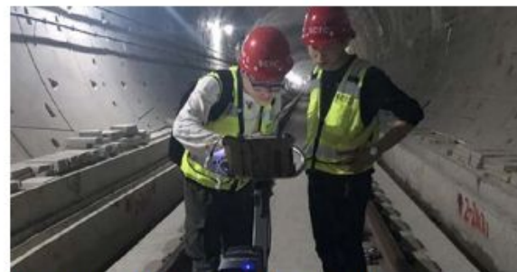
Контроль безопасности при строительстве железнодорожного туннеля
