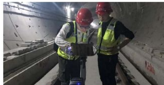
Контроль безопасности при строительстве железнодорожного туннеля
