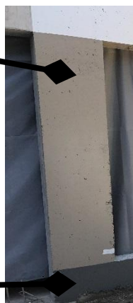
Кирпич плитка глазурованная (сохраняемая часть здания) или окраска в RAL 1019
