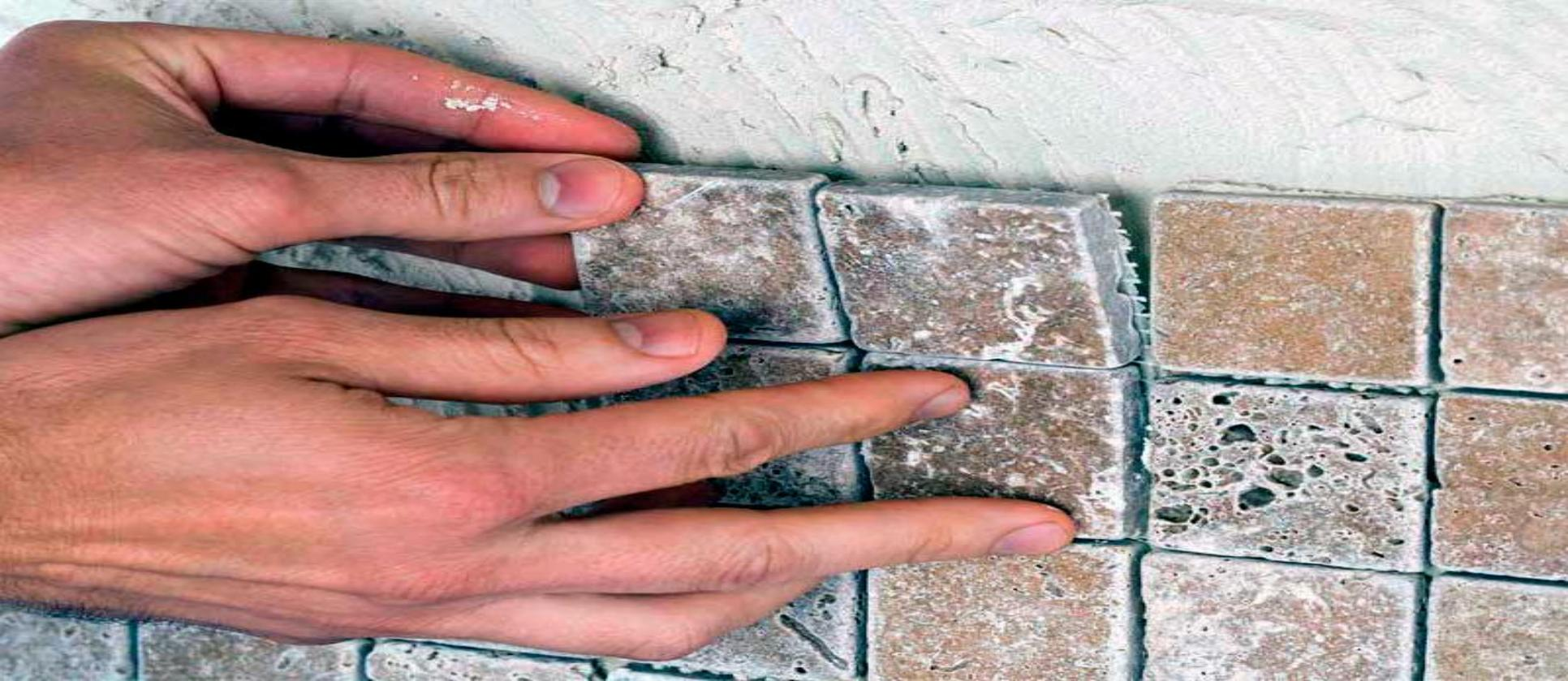
Способ прямой укладки заключается в выкладке изображения лицевой стороной вверх. Выкладку панно лучше производить на горизонтальной поверхности для удобства при работе. Элементы панно приклеиваются на сетку из стеклоткани, а затем уже переносятся на запланированное место. Швы затираются уже после закрепления готового панно на поверхности.
