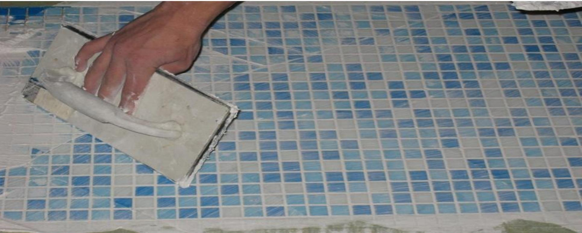
Сборка и выкладка панно из мозаики осуществляется вручную. Этот сложный и кропотливый процесс, который требует минимального опыта, огромного терпения и усидчивости. Для надежного крепления мозаичного панно к основанию следует использовать эпоксидные материалы. А применение эпоксидной затирки создаст дополнительную армирующую сетку. Она обеспечит дополнительную защиту мозаичного панно от случайных сколов.
