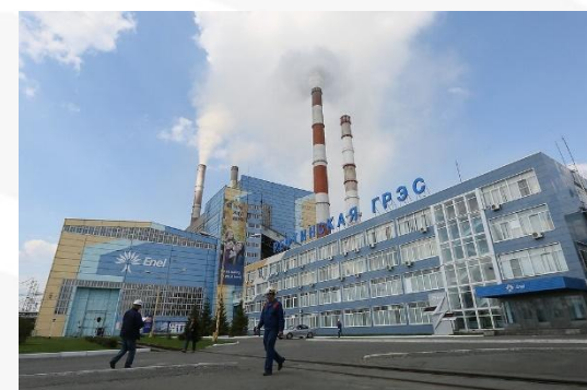
Рефтинская ГРЭС, Свердловская обл.
