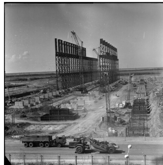
Строительство 3-го корпуса завода "Атоммаш".
