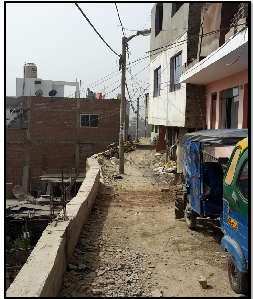
Imagen 24. Calles angostas y obstaculizada con vehículos y material de construcción. Falta de señalización del precipicio, lo que pone en riesgo tanto a personas que transitan por la vía como a las personas q viven en la parte inferior.
