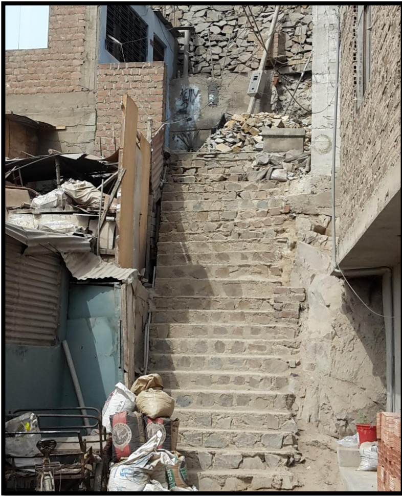
Imagen 23. Escaleras muy empinadas con imperfecciones y desniveles sin ninguna medida de seguridad como barandas, expuesta al desprendimiento de rocas de la parte superior.
