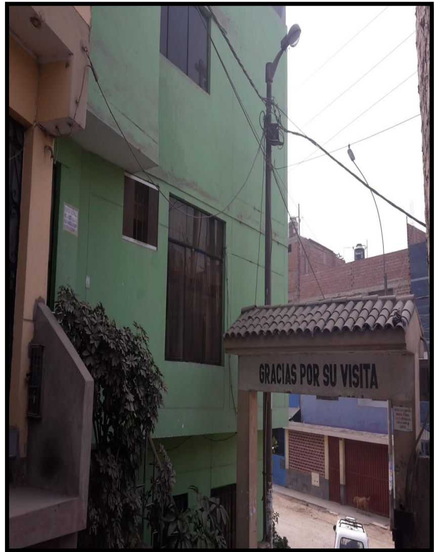
Imagen 20. Vivienda construida muy próxima a un poste de alumbrado público, además presenta invasión de las veredas con sus escaleras de acceso.
