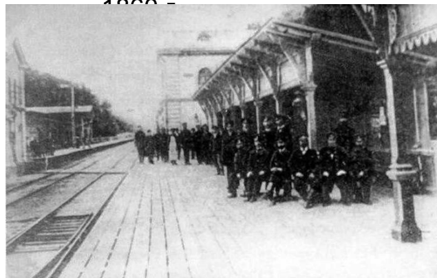
Вокзал станции Химки 1900 г.
