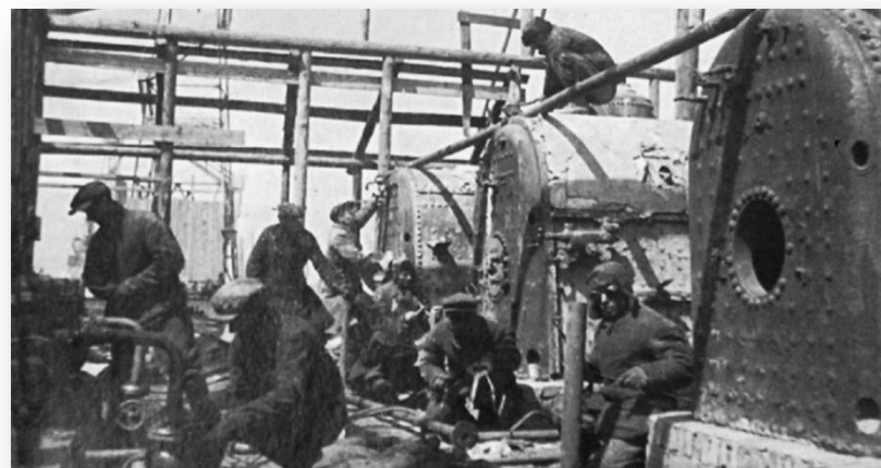
Монтаж оборудования на Сызранском нефтеперерабатывающем заводе
