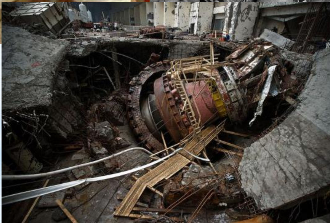
Последствия аварии на Чернобыле
