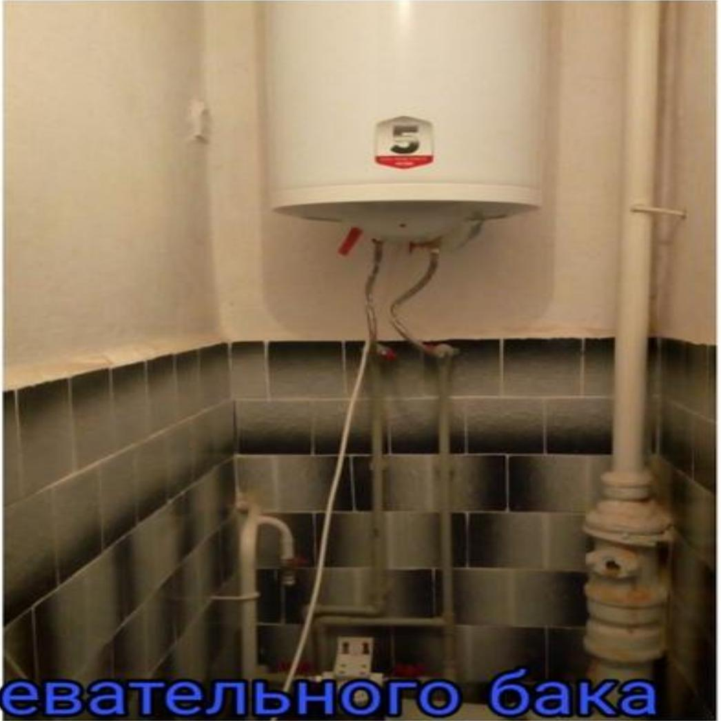
**Монтаж водонагревательного бака
