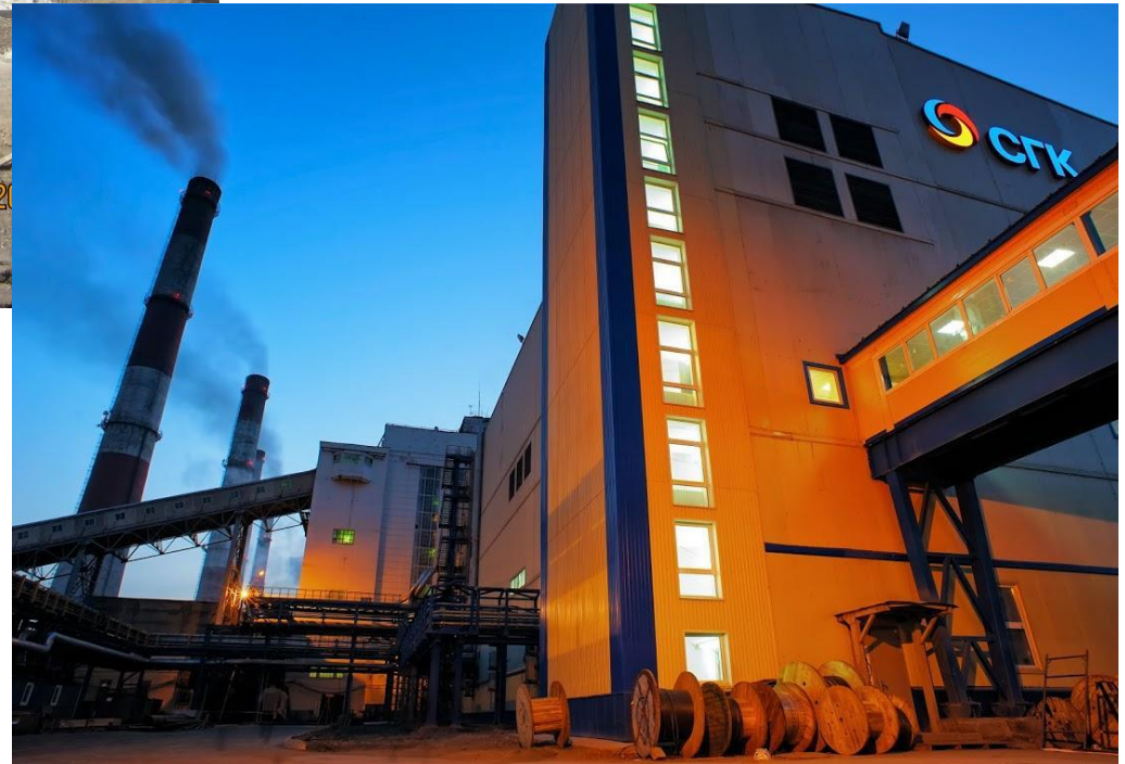
Строительство нового корпуса турбоагрегатов №№4,5
