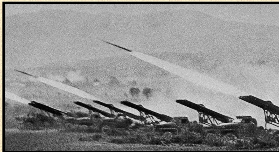
14 июля 1941 года в 15 часов 15 минут прогремел первый залп по врагу невиданного нового вида оружия - реактивной артиллерии. Семь советских установок залпового огня БМ-13-16 (боевых машин с 16 ракетными снарядами 132 мм на каждой), смонтированные на автомобильном шасси ЗИЛ-6 (вскоре получившие название «Катюша»), одновременно ударили по железнодорожной станции города Орша, забитой немецкими составами с тяжелой военной техникой, боеприпасами и горючим.
