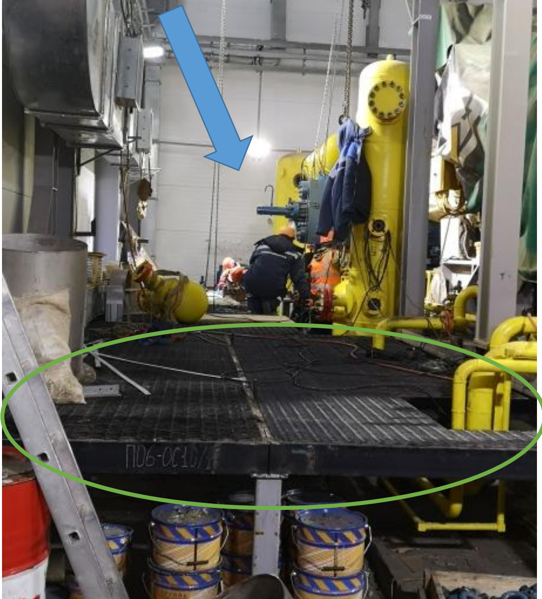
ПКУ11: Смонтировали площадку обслуживания с просечкой. Монтаж 1-ряда 4 ступени компрессора
