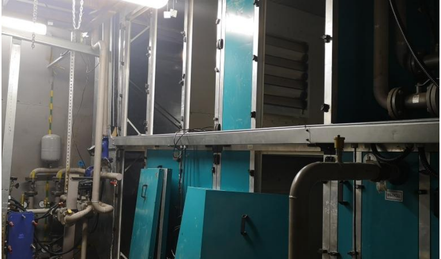
ПКУ – 12: Монтаж и подключение не завершено
