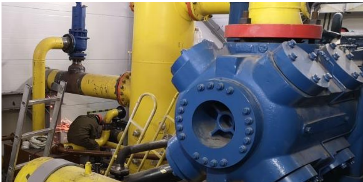
ПКУ – 12: Ведется монтаж оборудования и трубопроводов
