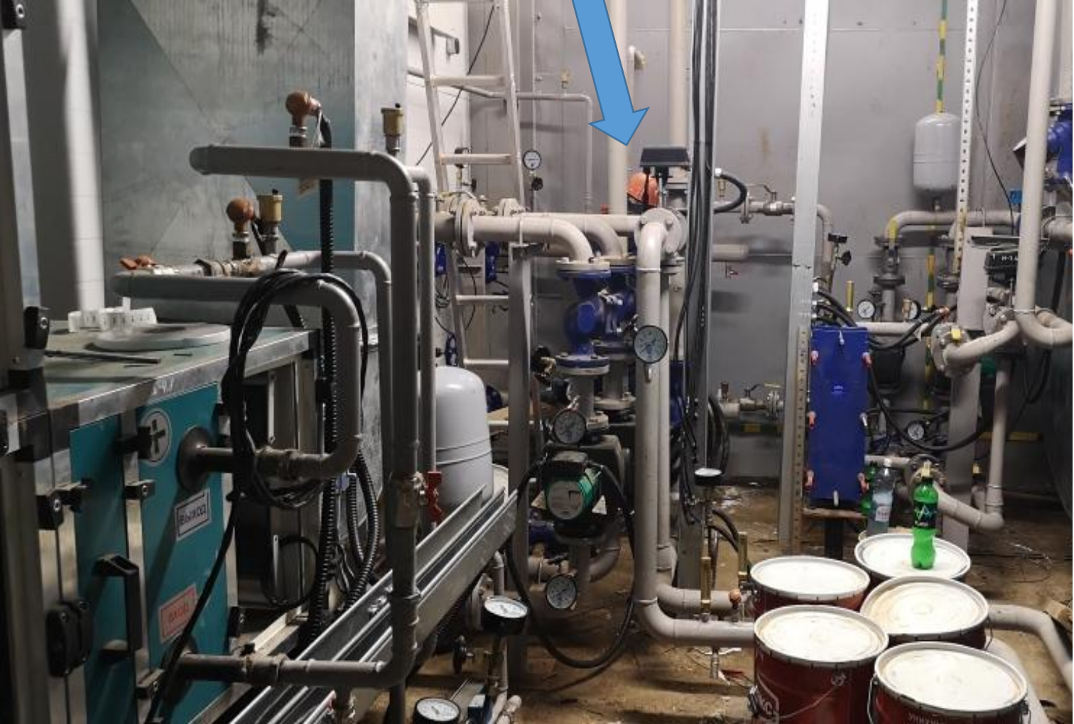
ПКУ – 12: Монтаж КИП обвязки вентиляционной приточно-вытяжной системы
