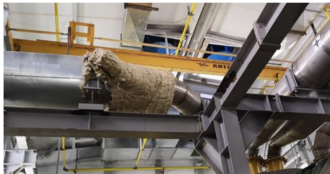
ПКУ – 12: Производится изоляция выпускной системы САТ
