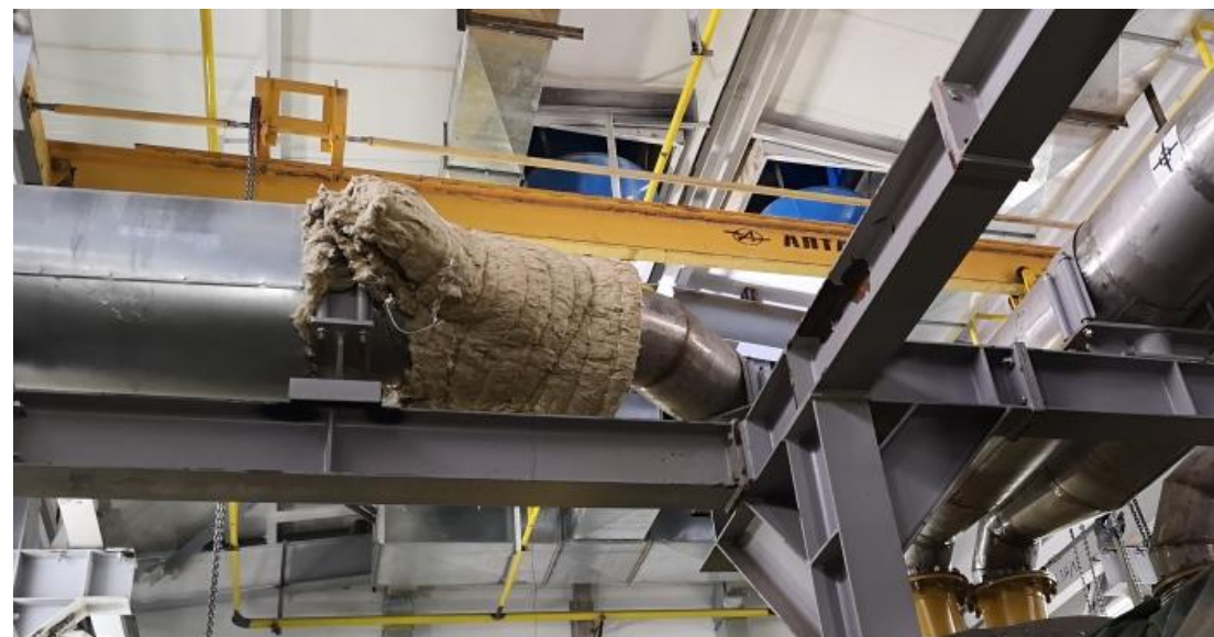
ПКУ – 12: Производится изоляция выпускной системы САТ
