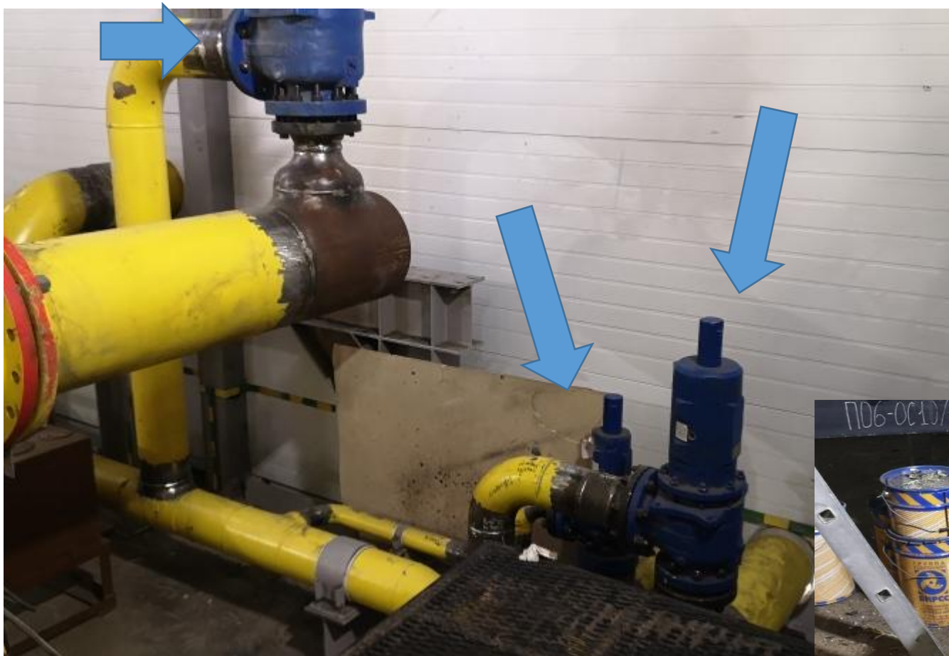
ПКУ11: Выполнен монтаж СППК
