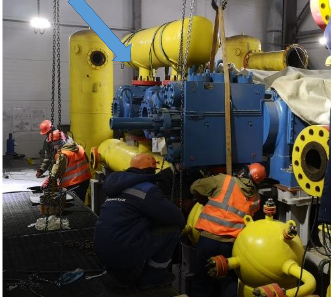
ПКУ11: Монтаж 1-ряда 4 ступени компрессора
