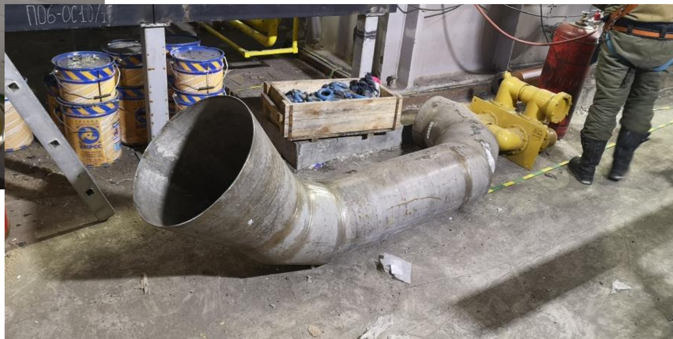
ПКУ-11: Подготовка к монтажу участка выхлопной системы
