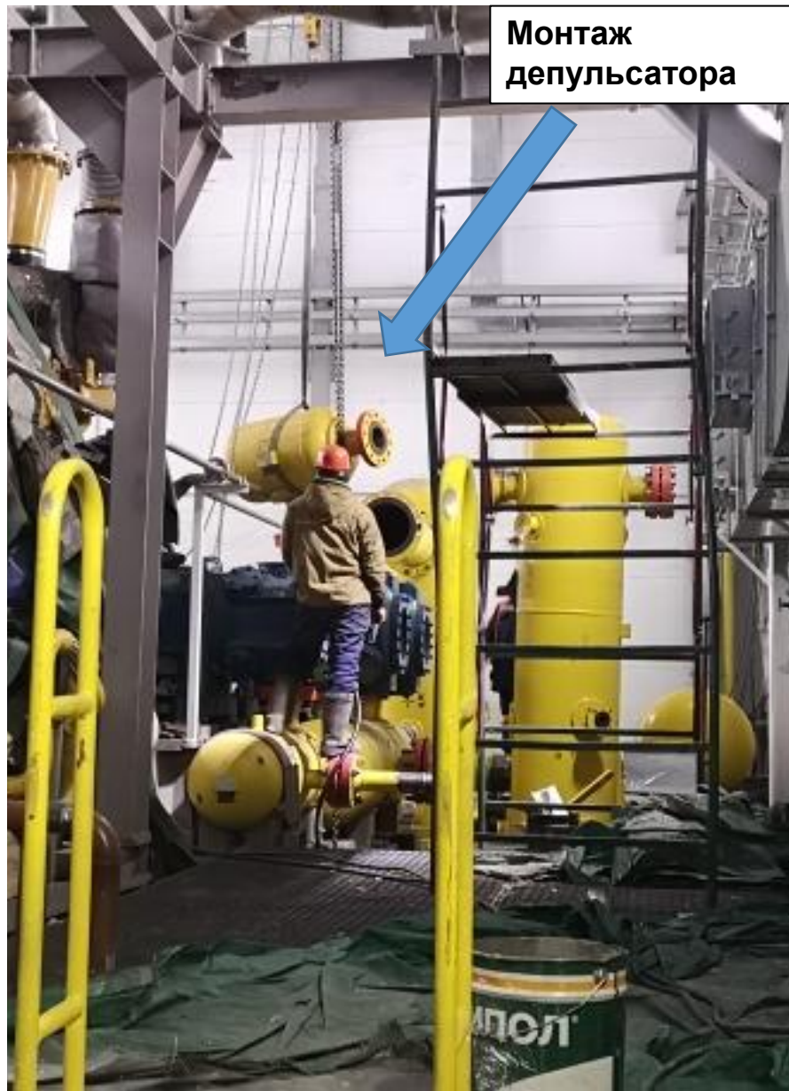
ПКУ – 12: Ведется монтаж оборудования и трубопроводов
