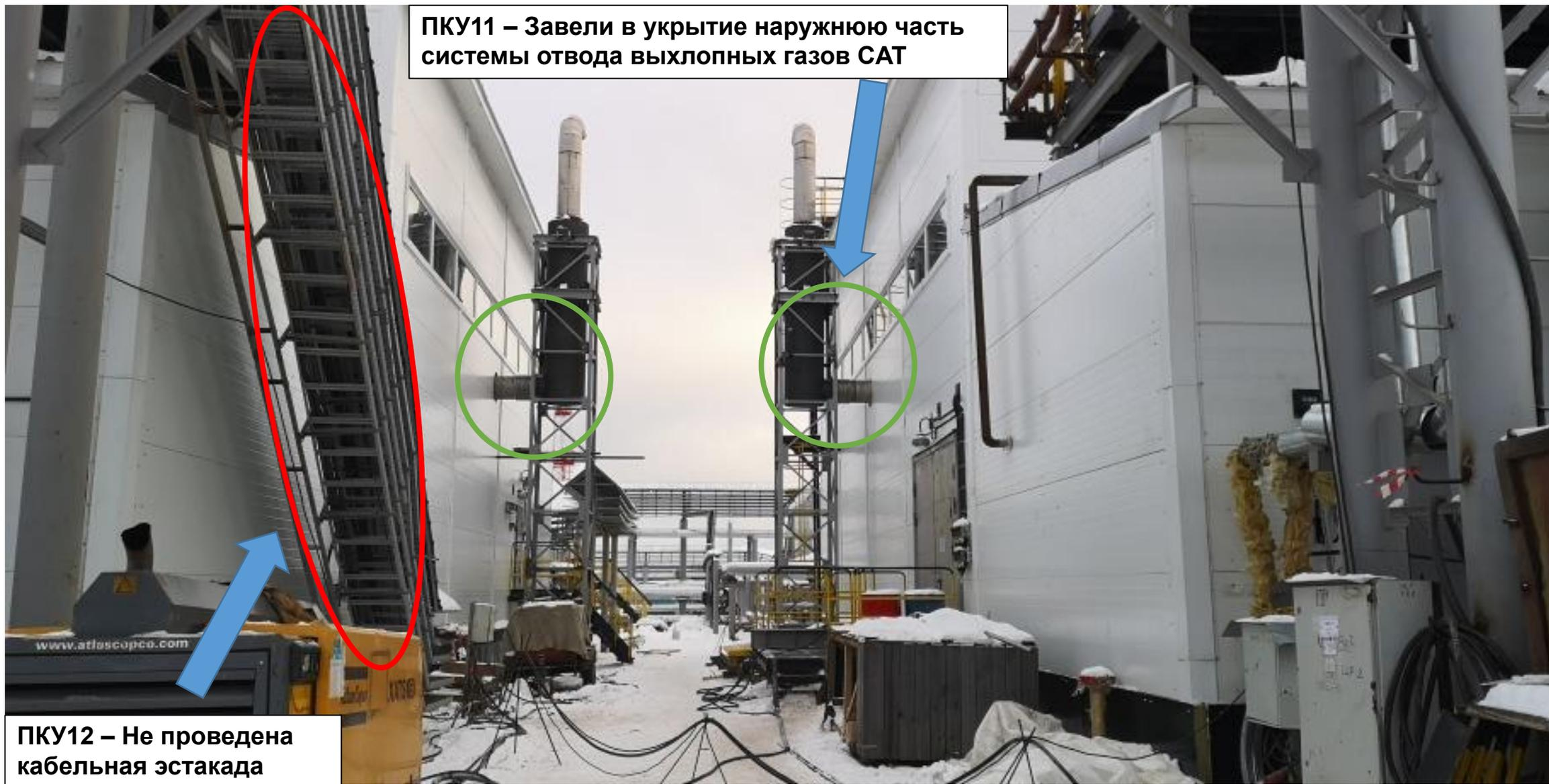
ПКУ11 – Завели в укрытие наружную часть системы отвода выхлопных газов САТ
