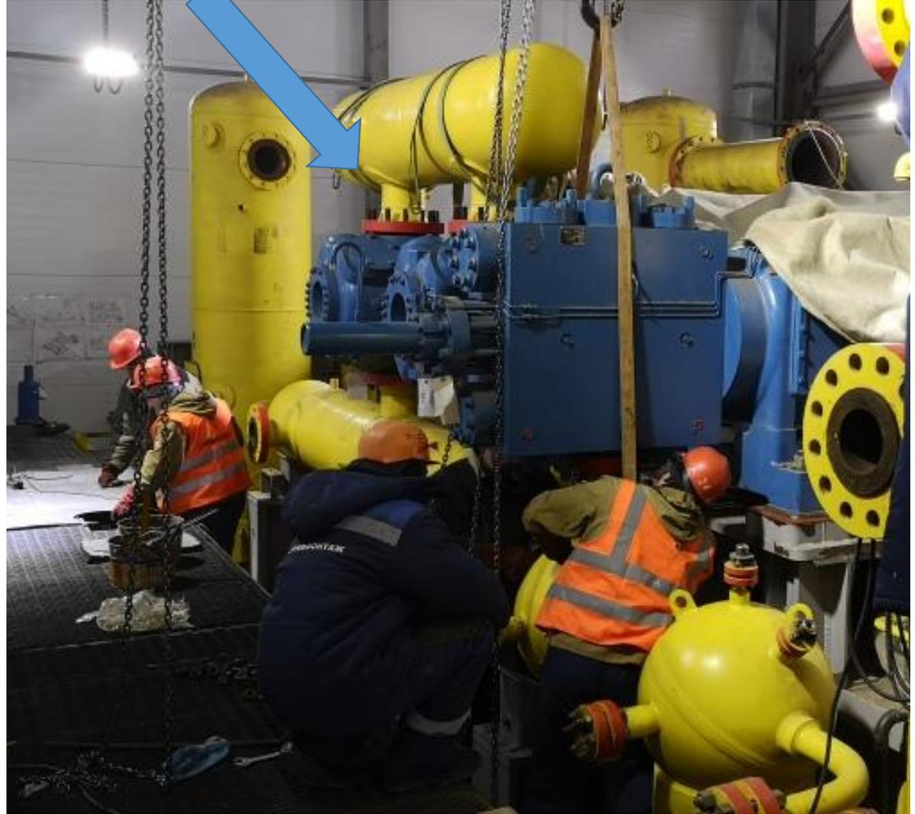
Не заизолирован трубопровод выпуска выхлопных газов. Наличие коррозии на балке
