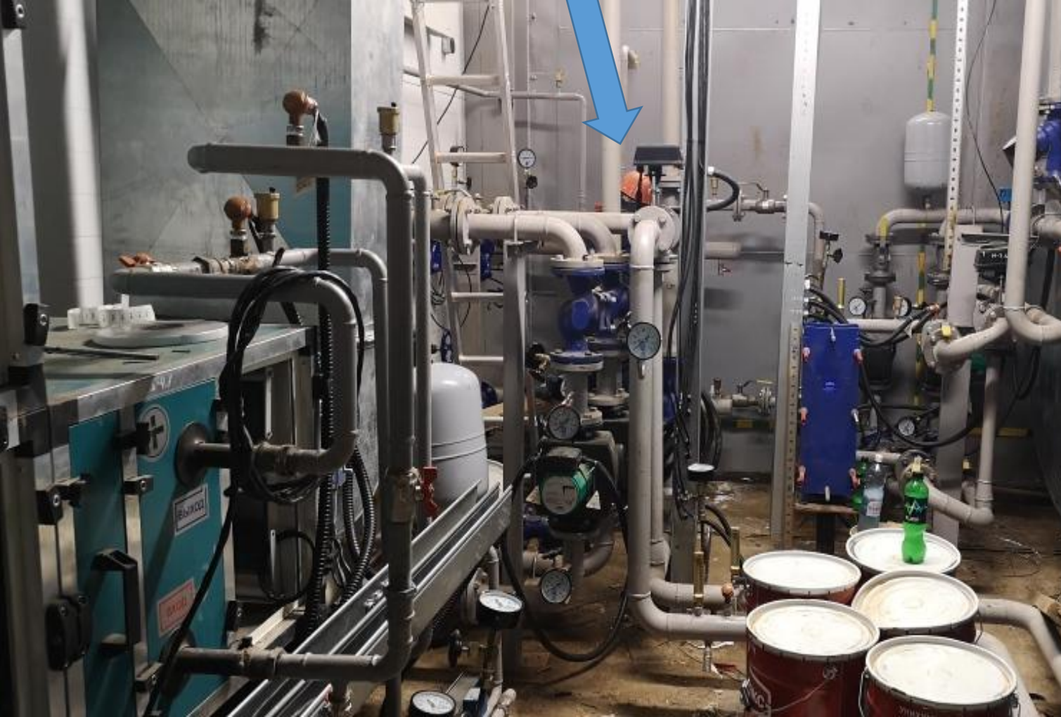
ПКУ – 12: Монтаж КИП обвязки вентиляционной приточно-вытяжной системы
