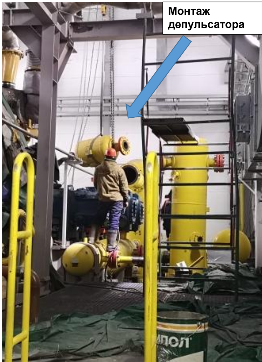
ПКУ – 12: Ведется монтаж оборудования и трубопроводов
