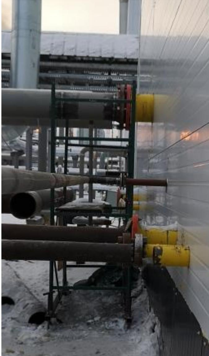
**Трубопроводы FG40 (Пусковой) и FG40(Топливный) заведены в укрытие ПКУ – 11. Трубопровод В20 не заведен**
