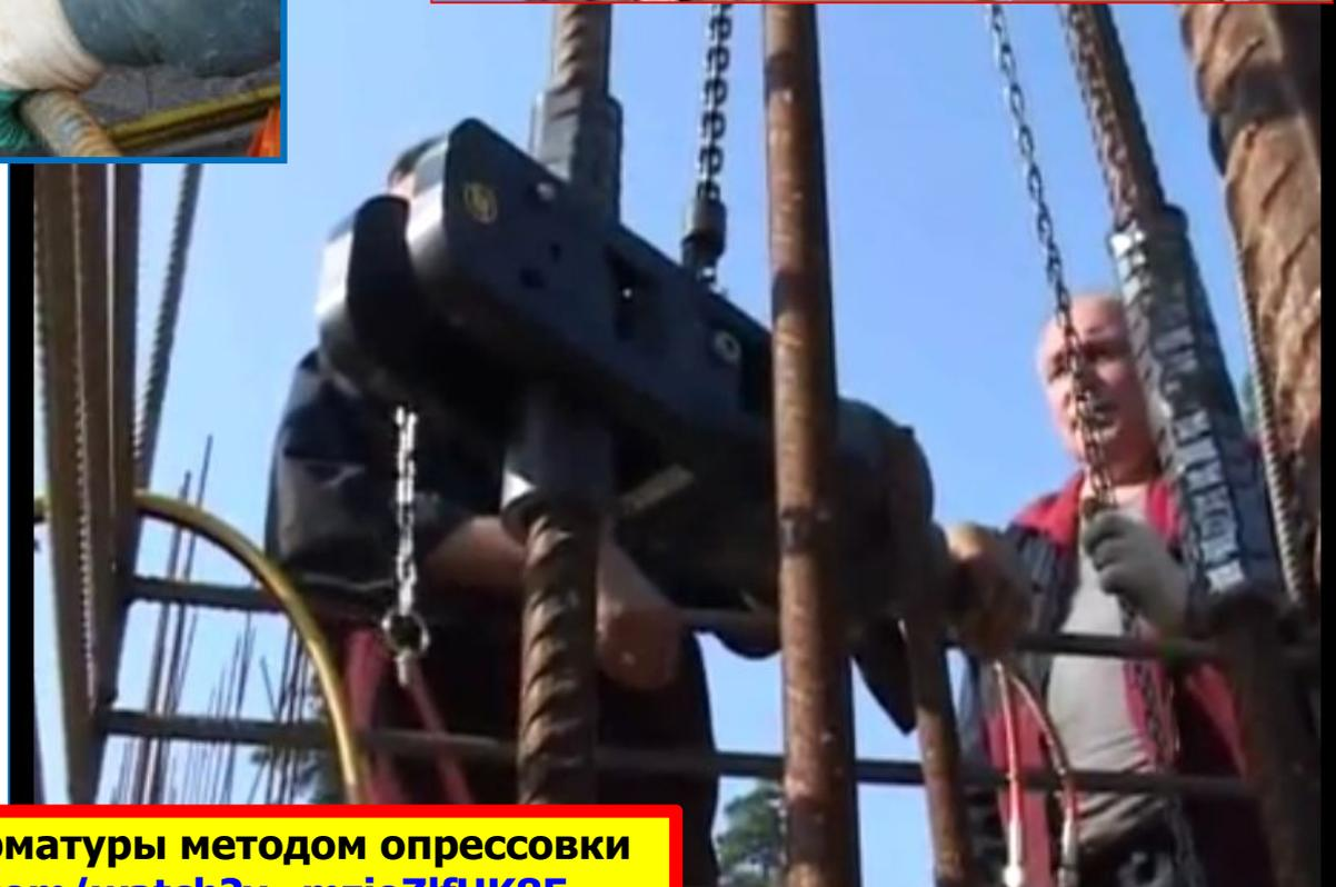
См. видео: Соединение арматуры методом опрессовки
