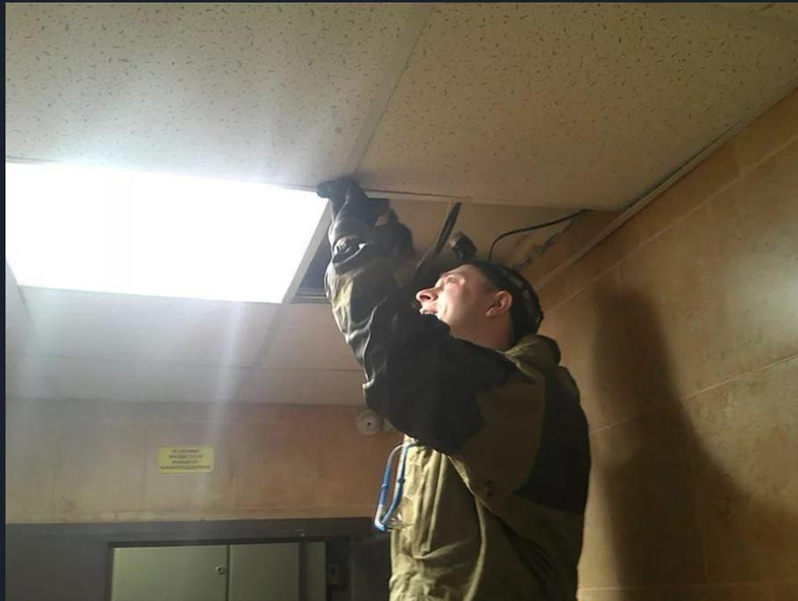
Аварийным называется освещение, которое при нарушении рабочего освещения временно обеспечивает возможность продолжать работу. Аварийное освещение устраивают в производственных помещениях, коридорах, проходах и проездах, на лестничных клетках. Светильники аварийного освещения отличаются от прочих светильников окраской и конструкцией; их присоединяют к электрической сети, не связанной с сетью рабочего освещения.
