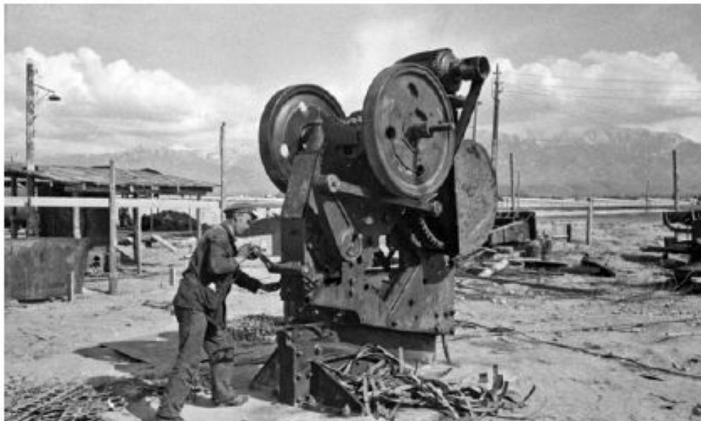
Монтаж эвакуированного оборудования. 1941 г.
