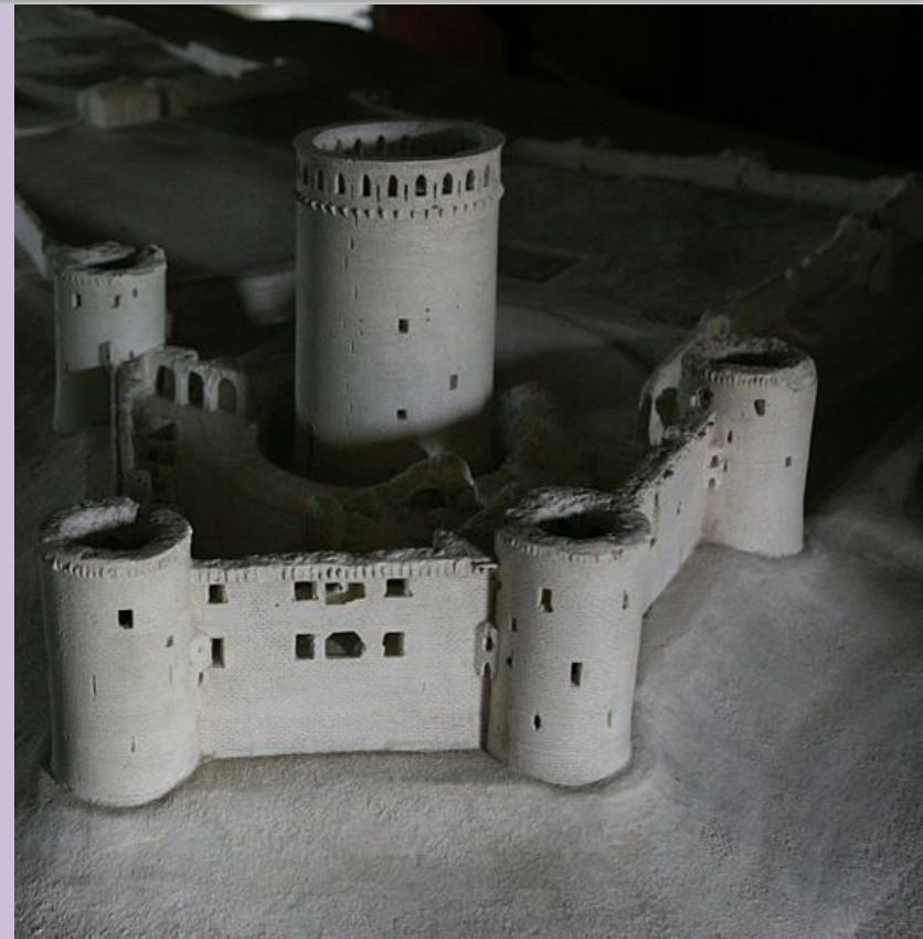
Замок Куси во Франции (Длина стен 2 400 м., диаметр донжона - 35 м., высота – 55 м., толщина стен – 7 м.)
