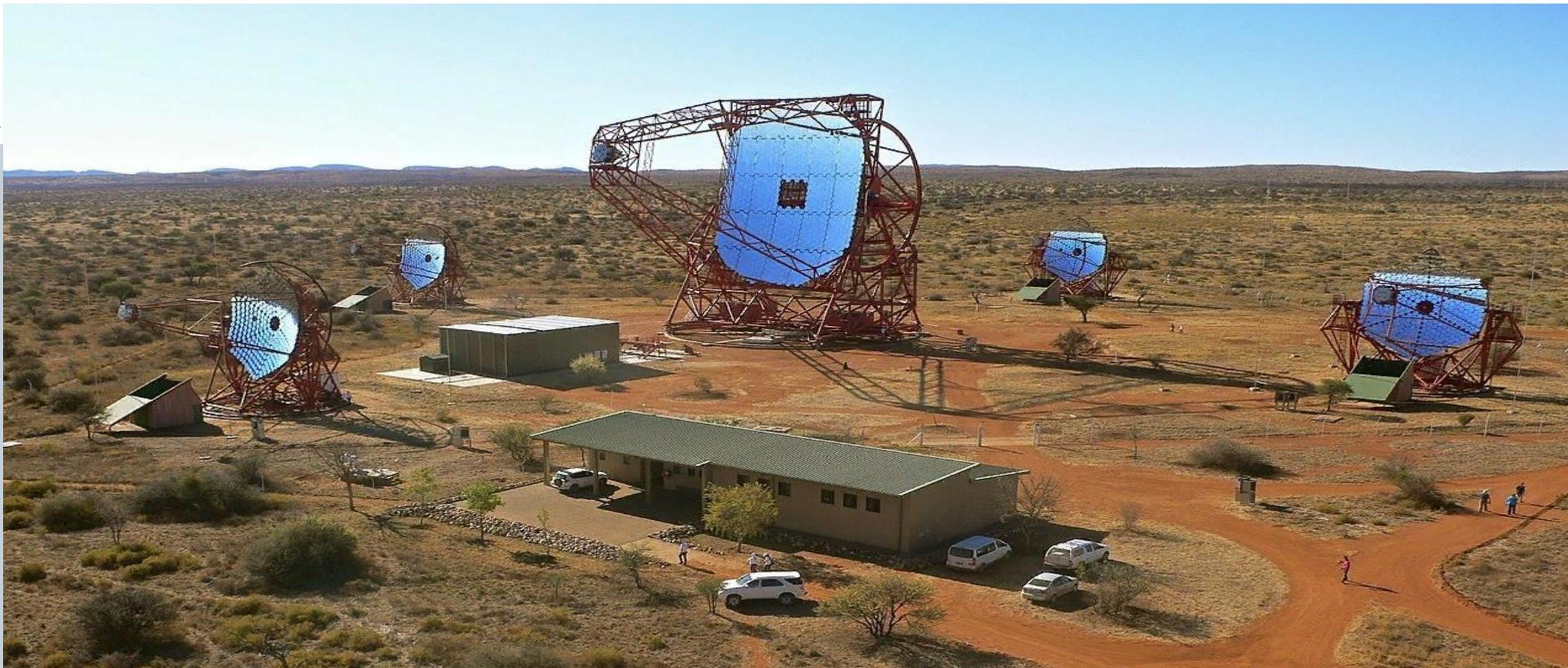
**Наиболее мощным на сегодняшний день гамма-телескопом является телескоп HESS (The High Energy Stereoscopic System), расположенный в Намибии, состоящий из 4 параболических тарелок диаметром 12 метров (на каждой закреплено 382 круглых зеркала диаметром 60 см), которые размещены на площадке размером 250 метров.**
