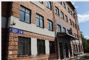
Корпус №4 по адресу: г. Казань, ул. Исаева, 12. Площадь 3100 кв.м.
