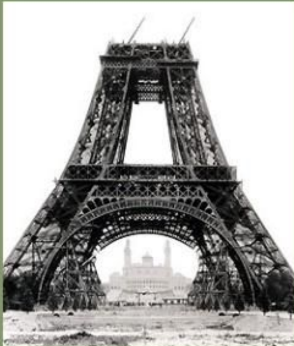
Строительство Эйфелевой башни
