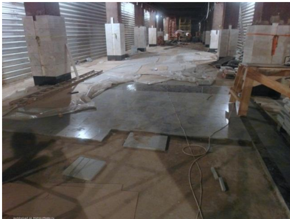
Укладка гранитного пола в московском метрополитене
