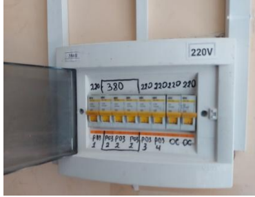
Отсутствует однолинейные эл.схемы щитков.
