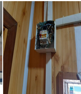
Эксплуатируются электрические приемники без защитных корпусов
