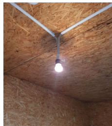
Электросветильниках нет защитных плафонов
