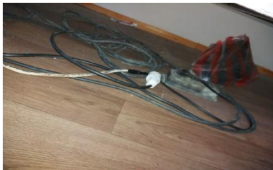
Масленные обогреватели используются через самодельных эл.переносок.
