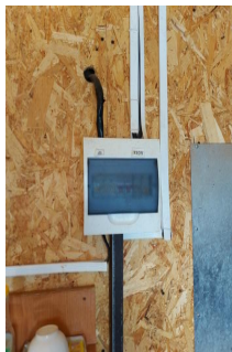
Кабеля без кабель каналов.
