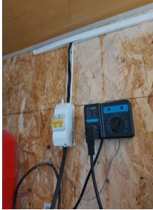
Кабеля без кабель каналов.
