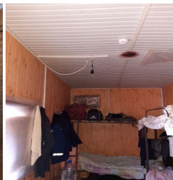
Электросветильниках нет защитных плафонов
