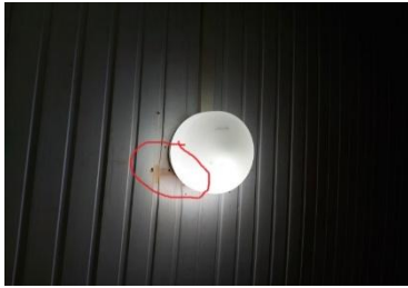
Пластиковый потолок расплавлен.
