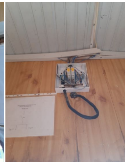
Эксплуатируются электрические приемники без защитных корпусов
