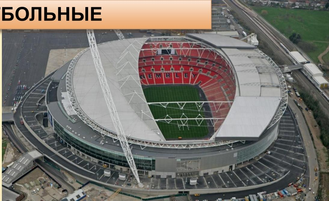
Арка занесена в книгу рекордов Гиннеса, как самая длинная структура крыши с отсутствием креплений. Незакрепленная арка удерживает вес всей северной крыши стадиона. На нее ложится чуть более 60% веса выдвигной южной крыши.
