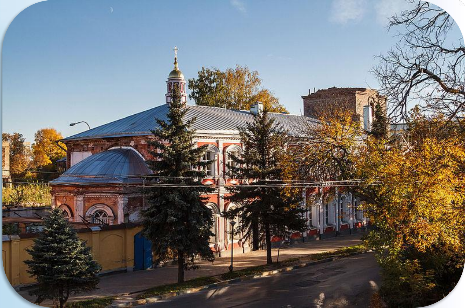
Церковь Александра Невского Нижний Новгород Основана в 1882 г.
