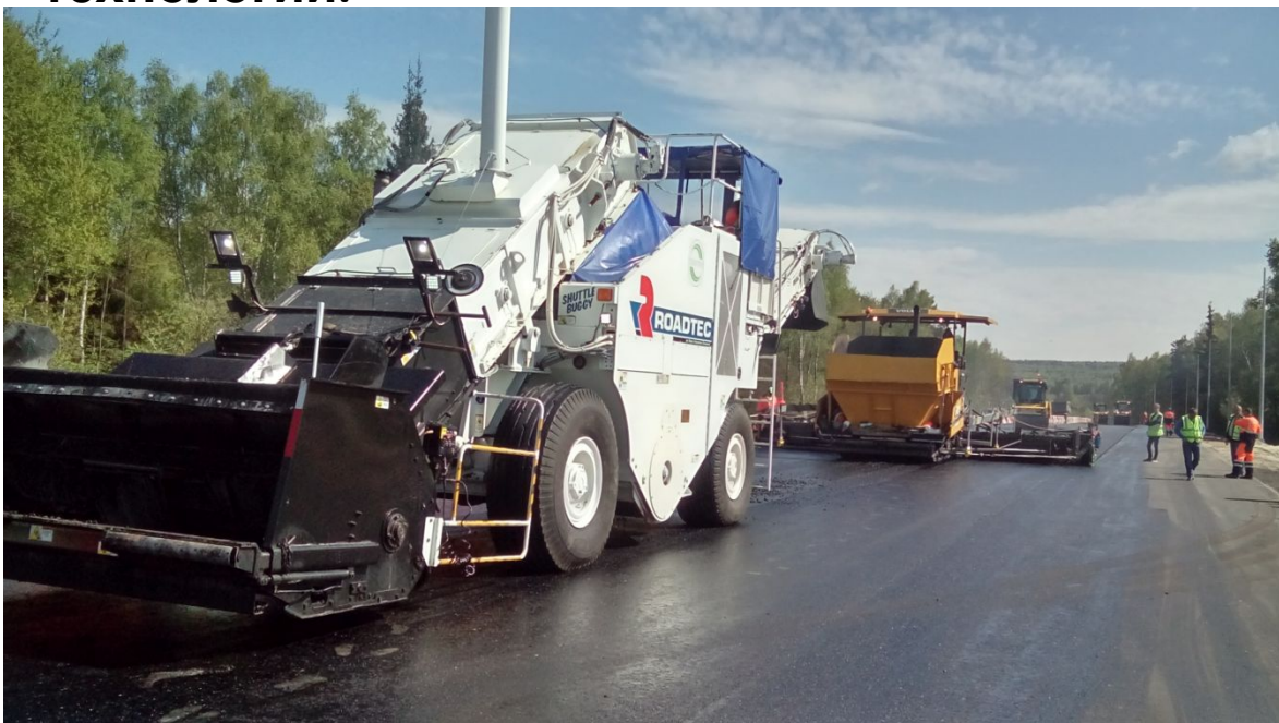
Применение антисегрегационных перегружателей Shuttle Buggy с 2003 года
