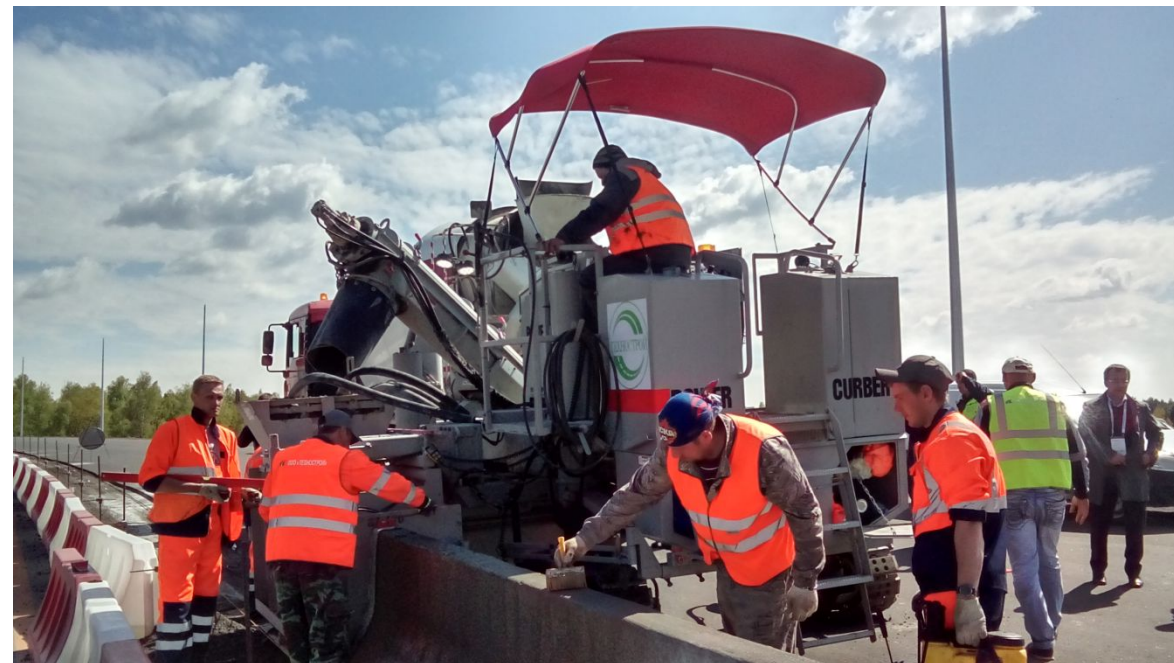
Применение укладчиков со скользящими формами для строительства бетонных барьерных ограждений с 2015 года
