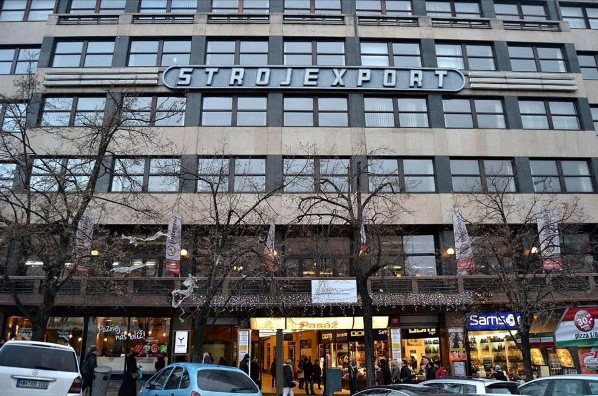
Palác pojišťovny Fénix, známý též jako Strojexport, je jednou z prvních konstruktivistických staveb v Praze. Pochází z konce 20. let minulého století, autorem průčelí je architekt Josef Gočár
