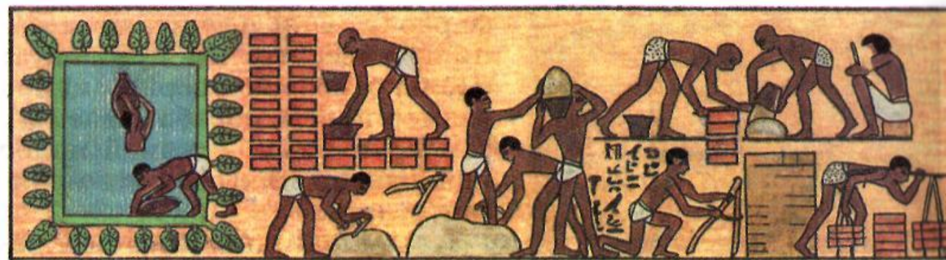
Строительство дома. Древнеегипетская роспись.
