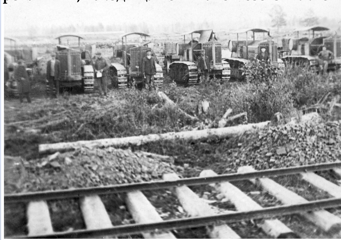
Техника на строительстве цеха колес Гриффина 1932г.
