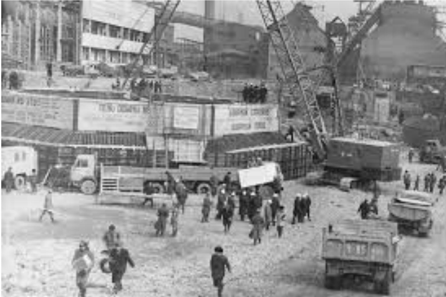
В июле 1942 в районе озера Смолино развернулось строительство ЧТПЗ. Станки монтировали под открытым небом, потом делали навес из досок, и оборудование сразу же включалось в работу. Менее года потребовалось для того, чтобы запустить трубное производство.
